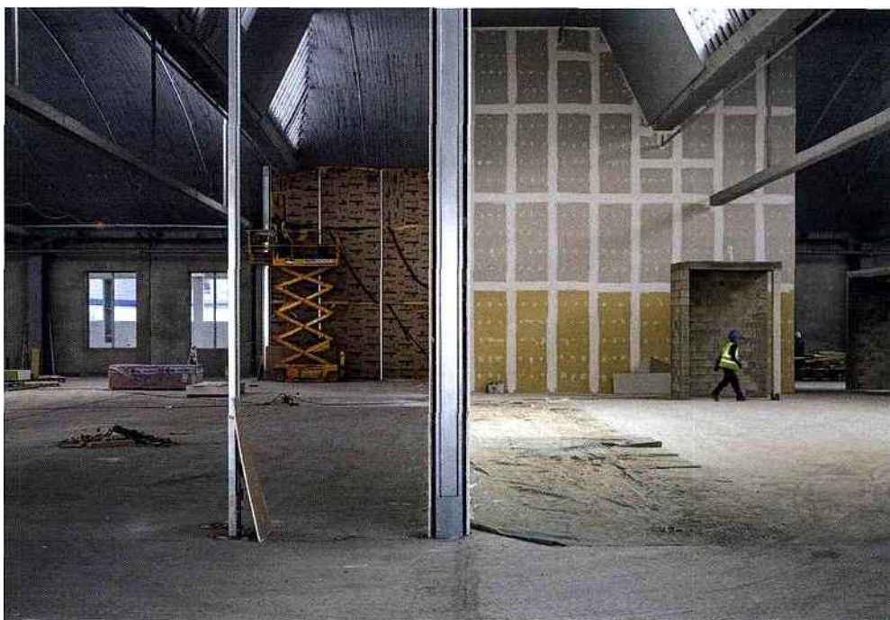
Les parois intérieures sont constituées de plaques de plâtre sur ossature métallique avec isolation en laine minérale. (Photo SDGB France)
