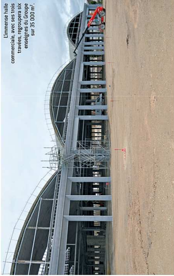
Cette magnifique halle, conçue par les ingénieurs Paul Peirani et Bernard Laffaille, est couverte de voûtes paraboliques.
