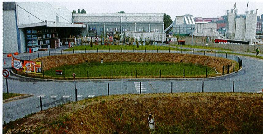
Le traitement de l'ensemble des eaux usées et pluviales par phytorestauration a permis d'éviter tous les travaux de génie civil pour le raccordement au réseau d'assainissement. (Doc. Ph.D.)
